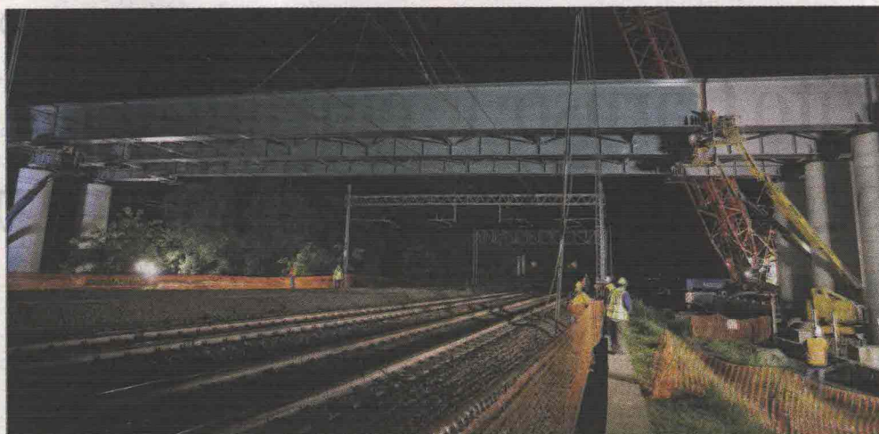
La posa del viadotto della Tem che scavalca la linea ferroviaria Milano-Brescia.
