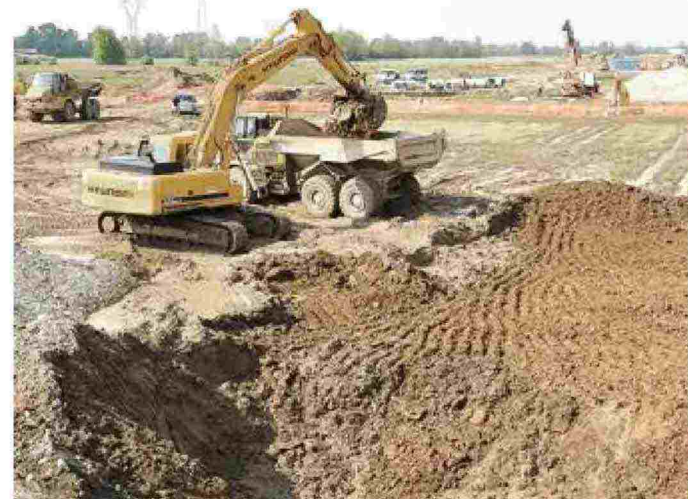
RUSPE AL LAVORO Tre immagini dei cantieri della Tem in zona Paullo
