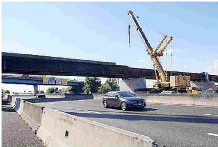
IL VIADOTTO La struttura fissata la notte scorsa a Cerro (Np)
