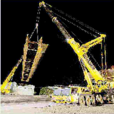
I LAVORI Una fase del varo del ponte che permette di scavalcare la Milano-Napoli a Cerro al Lambro
