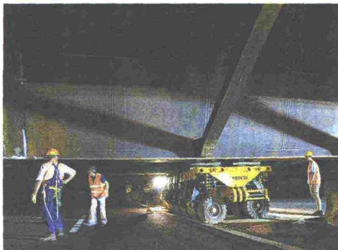
LAVORI SENZA SOSTA I tecnici all'opera ma stavolta minori i disagi
