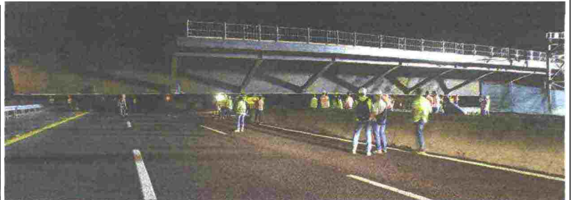
UN'OPERA COLOSSALE Nelle foto, alcuni momenti tipici della posa del maxi impalcato da 400 tonnellate che scavalcherà l'autostrada
