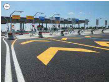
Il nuovo casello dell'arco Teem
