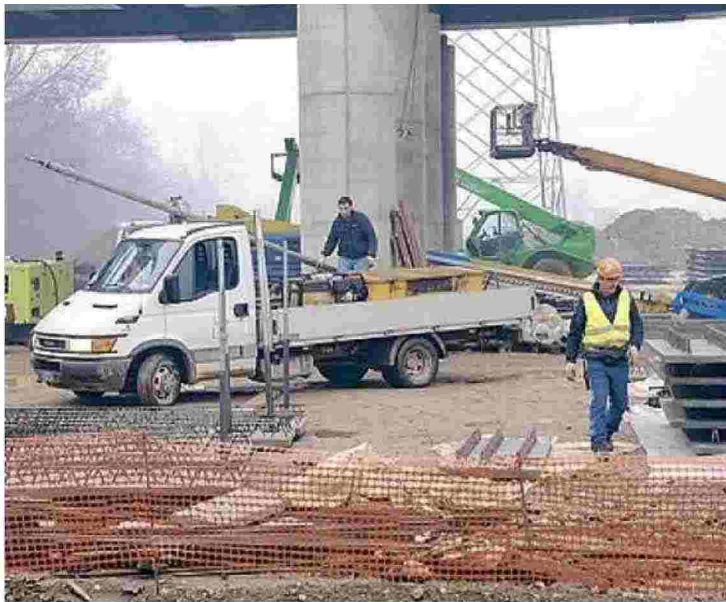
LAVORI L'arco Teem collegherà la Brescia-Bergamo-Milano alla rete viaria dell'Area Metropolitana attraverso i due svincoli che connettono alle strade provinciali Cassanese e Rivoltana
