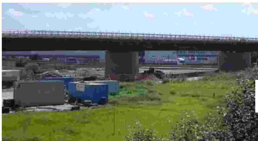
Alcune immagini aggiornate dei viadotti Tem
