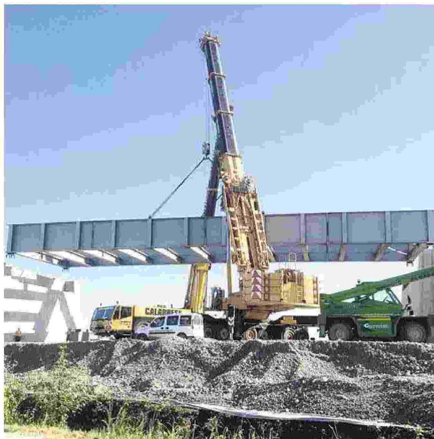
IL MAXI INTERVENTO Le gru ieri mattina al lavoro per la posa del viadotto (foto Bianchi)
