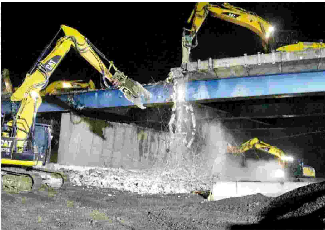
NOTTE IN BIANCO Le ruspe hanno lavorato fino all'alba per abbattere il viadotto di Riozzo e sgomberare le macerie
