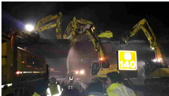
Demolizione di un ponte sull A4, foto monica buzzini
