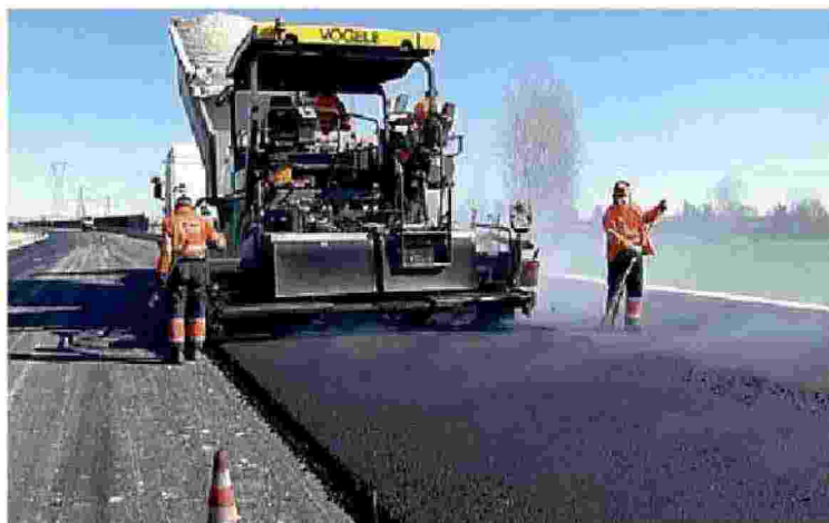
AVANTI La stesa dell'asfalto drenante e i lavori sul ponte del Lambro
