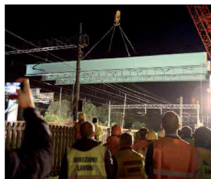
Una gru di 76 metri ha collocato la carreggiata che sovrasta la ferrovia Milano-Bergamo
