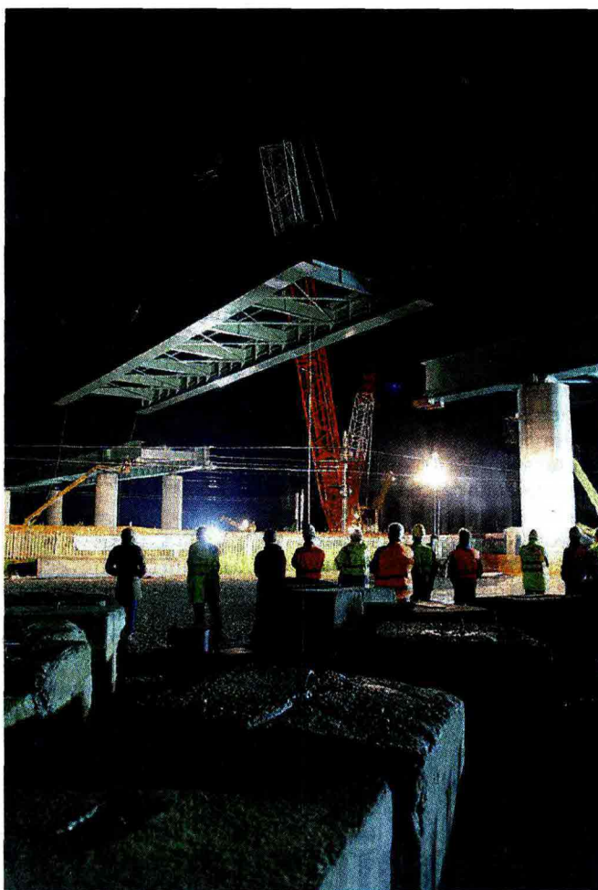
Le operazioni di posa del manufatto che collega Brebemi e Arcoteem
