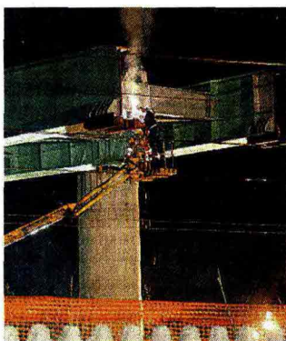
La saldatura dei blocchi
