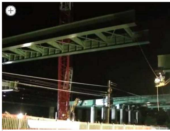
Un momento della posa in opera del viadotto Teem-Brebemi (Foto by *)
