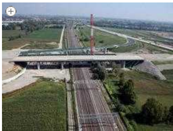
Sovrappasso TEEM ferrovia Mi-Bg Melzo-Pozzuolo
