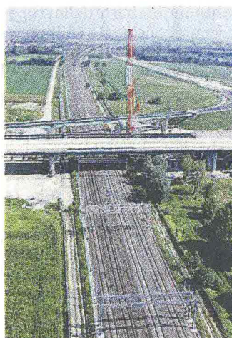
Uno dei cantieri lungo la Teem
