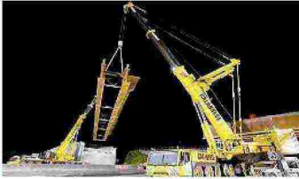
La posa del ponte
