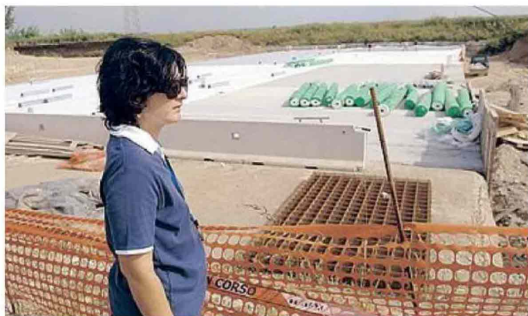
IL CANTIERE Prosegue il maxi cantiere della tangenziale est esterna per realizzare il sottopasso del Naviglio Martesana
