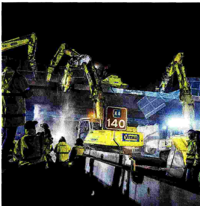
La demolizione del cavalcavia nell'ambito della Teem Milano FOTOBORG
