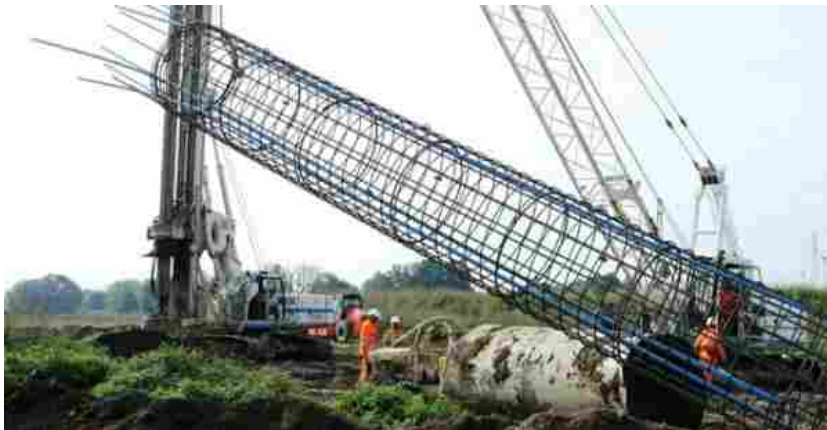
Cantiere Tem I lavori proseguiranno anche a Natale
