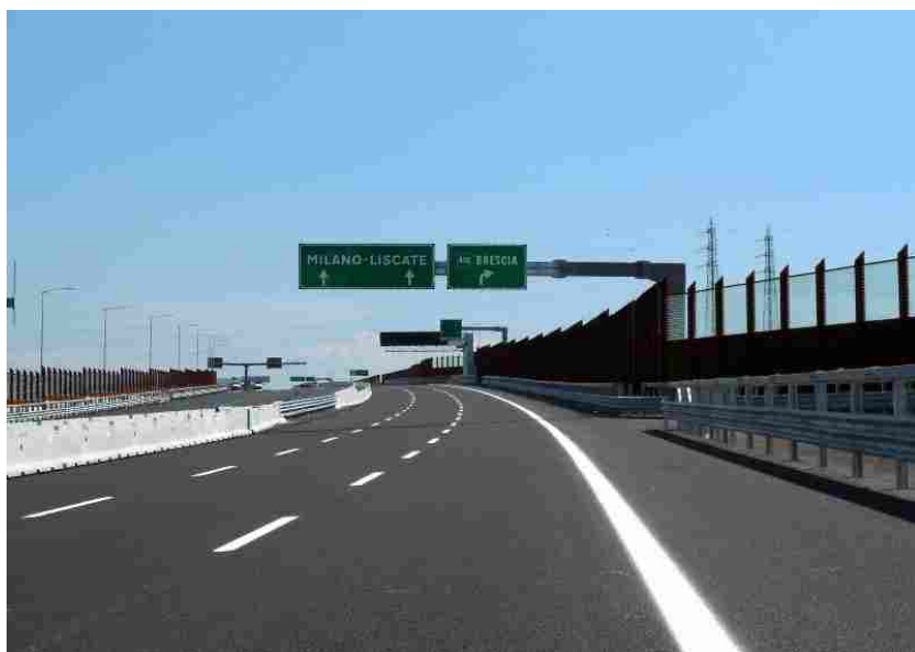
Tangenziale esterna di Milano Nuove corsie
