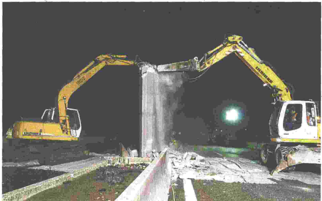
LAVORI IN AUTOSTRADA Uno degli interventi più spettacolari del 2014, la demolizione del cavalcavia a Bascapé
