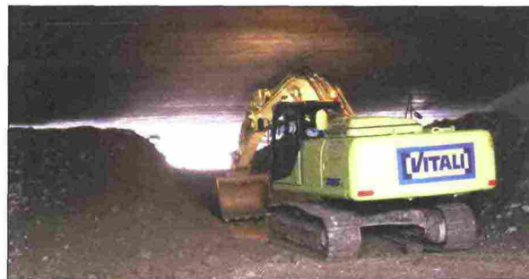
2. Il breakthrough della galleria di interconnessione tra la A58 e la soprastante A4
