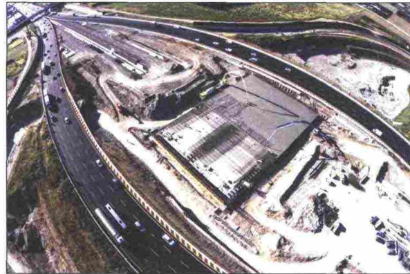
3. La doppia varice realizzata sulla A4 per consentire la realizzazione della galleria di interconnessione
