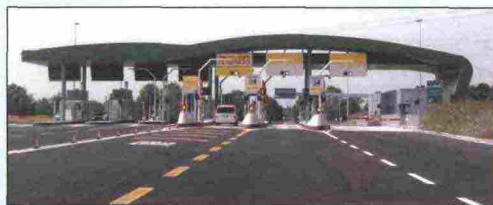
4. Il casello di esazione pedaggio di Treviglio
