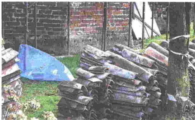
IL CANTIERE Le immagini dei lavori di restauro dell'Oratorio di Rossate
