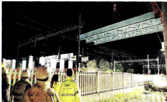
La posa dello scheletro metallico della carreggiata di Teem sopra i binari
