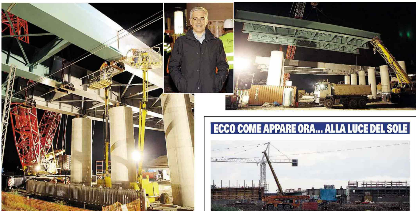
Due momenti della posa notturna del supercavalcavia e, al centro, l'ad di Te Spa Stefano Maullu
