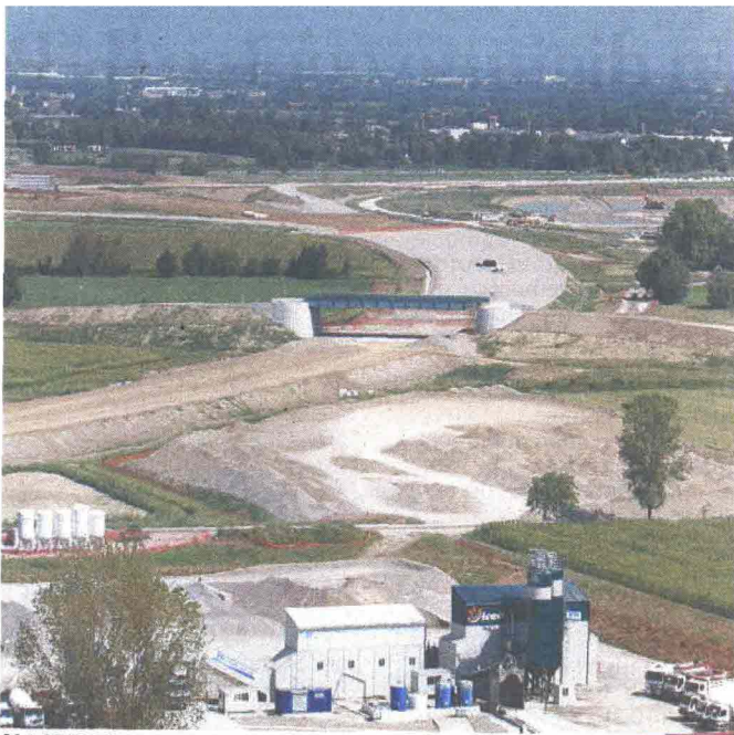
ALLARME RIENTRATO Qui sopra, l'area cantiere per realizzare la Tem
