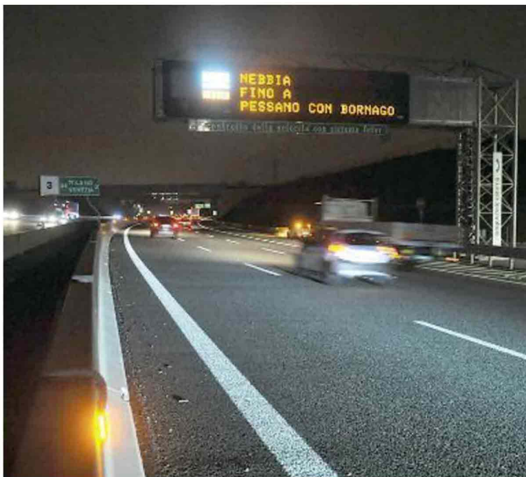
HI-TECH La nuova illuminazione installata sul tracciato di Tangenziale est esterna si accende automaticamente
