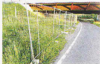
Le reti che sono state installate
