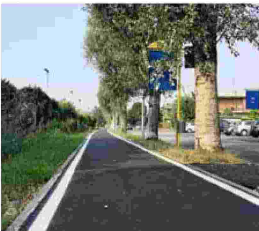
La pista di via Emilia Romagna è stata riqualificata.
