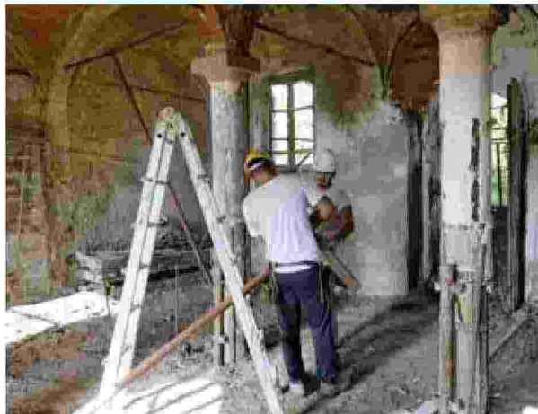
I lavori per il recupero di Cascina Triulza.
