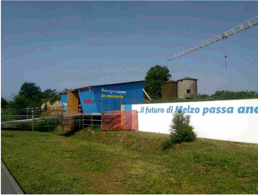
Foto - La terrazza per seguire i lavori
