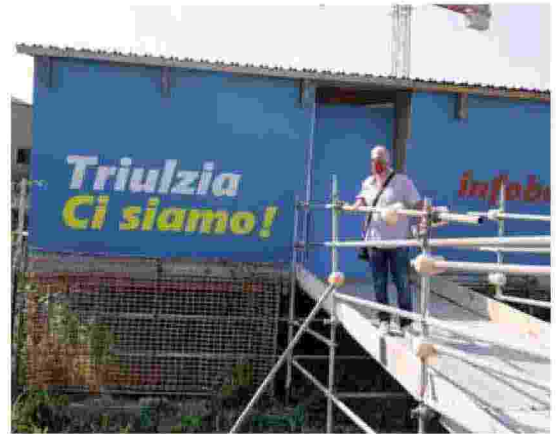
Il terrazzo degli "umarell", per chi vuol seguire i lavori per il recupero della Cascina Galbani.
